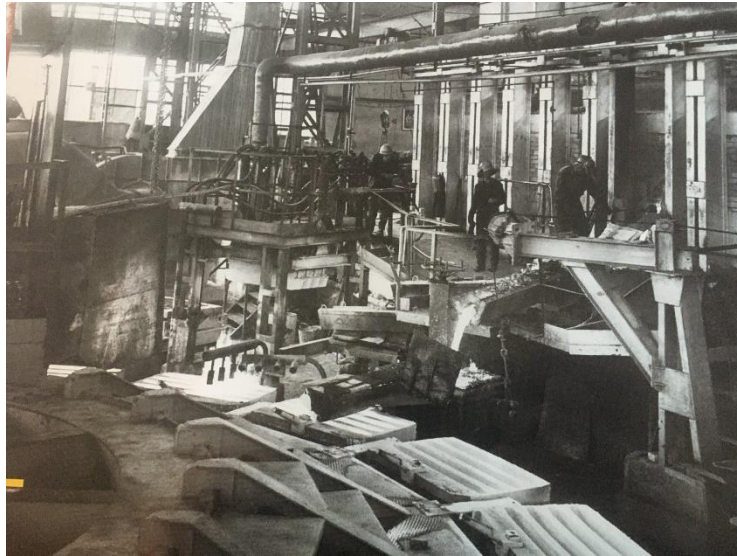
Fot. 2. Huta Miedzi „Głogów” w budowie ok. roku 1970
